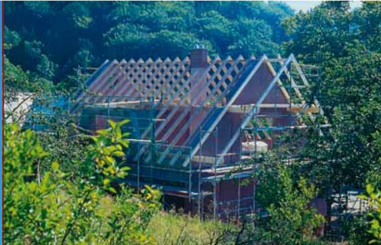
Die Dachüberstände betragen entsprechend dem Dachziegelraster an der Giebelseite ca. 20 cm, an den Traufen ca. 50 cm.
